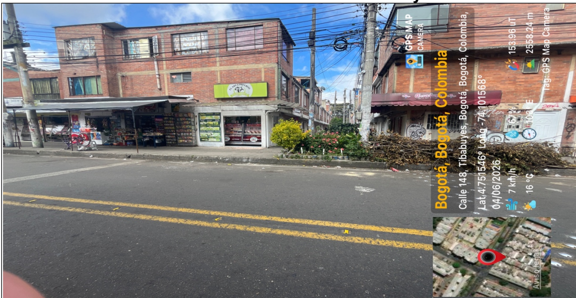
Foto 1. Vista general sitio
