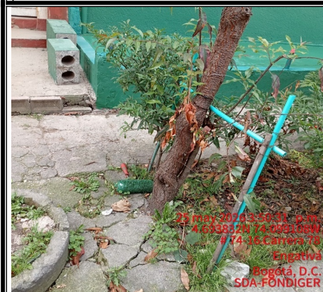
Foto 5: Vista detalle de la afectación a la placa de concreto.
