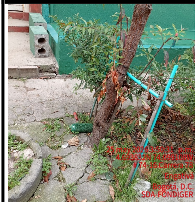
Foto 5: Vista detalle de la afectación a la placa de concreto.
