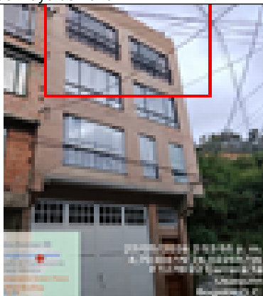
Fotografía 5. Pisos construidos y terminados en la vivienda con dirección LR 1 E 127 B 08.
