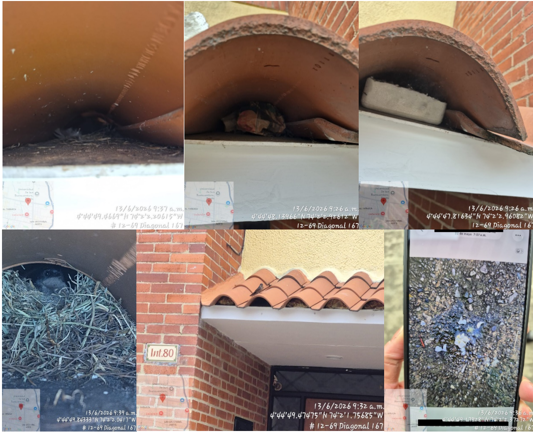
Fotografías 1 a 9. Evidencia de la visita técnica realizada en el CR Urbanización Villas de Aranjuez MZ 39 PH, el 13 de junio del 2026.
