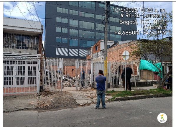
Imagen 2. Estado actual de la obra.
