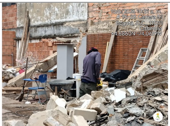
Imagen 4. Personal aún en etapas de demolición con uso de martillo neumático.
