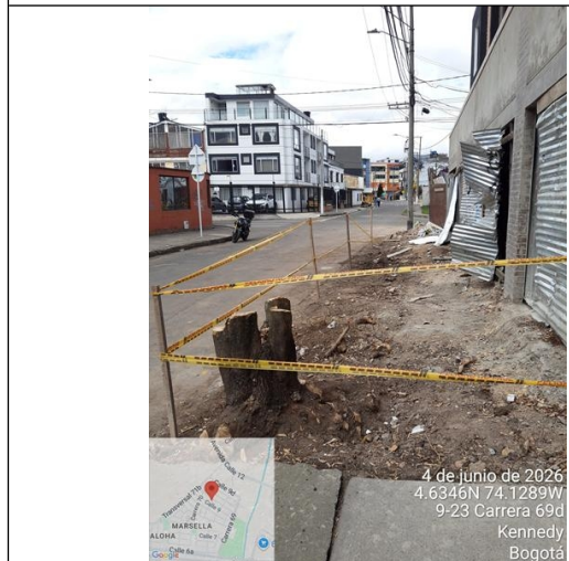
Foto 7. Vista general #3 del deterioro a zona verde de espacio público del costado oriental de la dirección.
