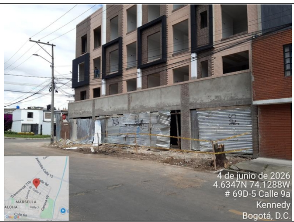
Foto 10. Vista general estado actual de espacio público del costado oriental de la dirección.
