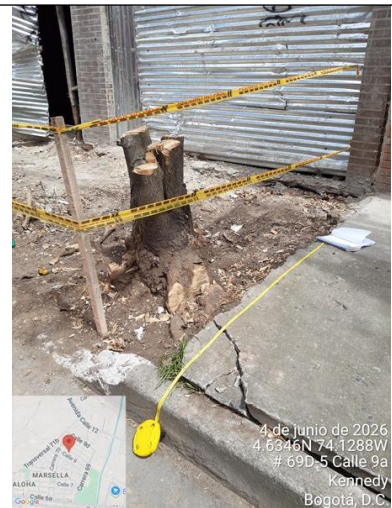
Foto 8. Vista general #1 de medición realizada en terreno.
