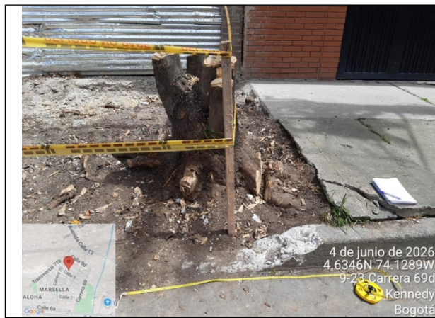
Foto 9. Vista general #2 de medición realizada en terreno.
