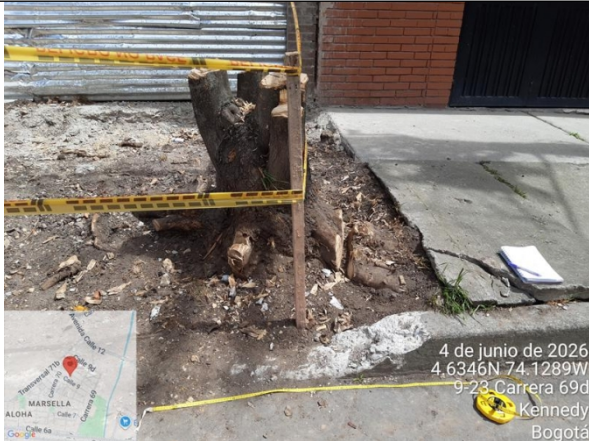
Foto 9. Vista general #2 de medición realizada en terreno.
