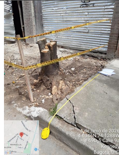
Foto 8. Vista general #1 de medición realizada en terreno.
