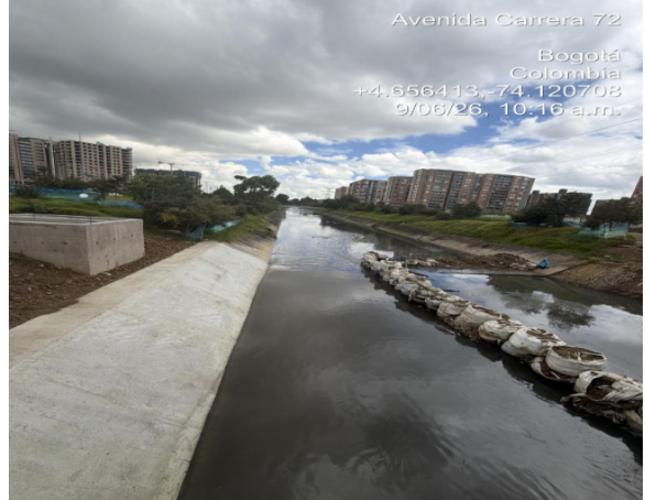
Fotografía No. 4 Presencia de estructura de contención provisional, aparentemente conformada por elementos tipo geotextil (sacos)
