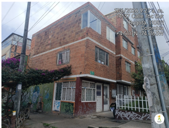
Fotografía 1. Vista panorámica de la vivienda con dirección Calle 76C Sur No. 14 – 66
