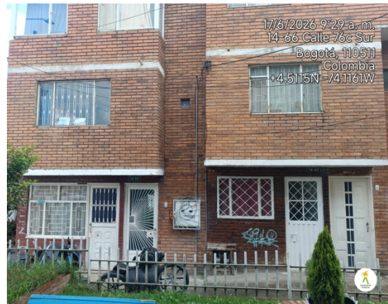
Fotografía 2. Viviendas contiguas sin aparentes trabajos constructivos en la zona.
