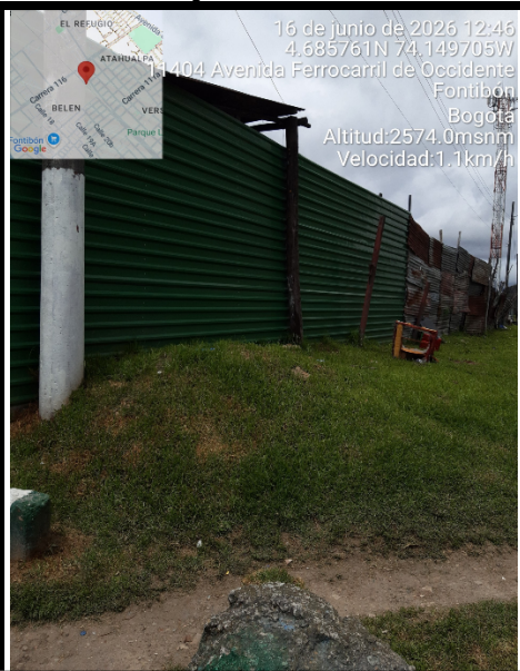
Foto 2. Vista general del espacio
