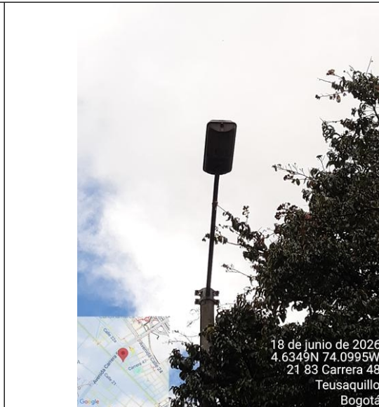
Foto 6. Estado actual de luminaria #1 observada en el sector.
