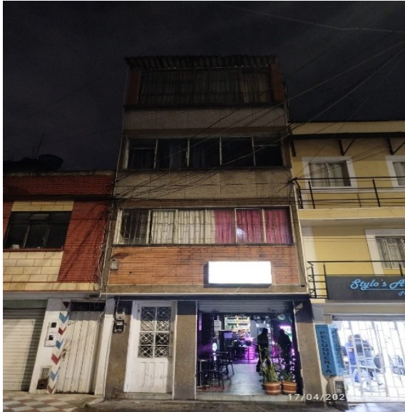
Fotografía No. 1. Vista general del predio objeto de seguimiento ubicado en la TV 69 B BIS No. 73 A – 12.
