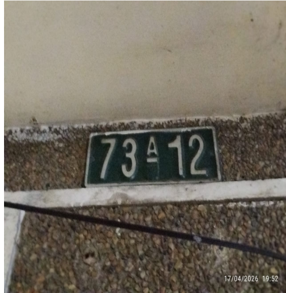
Fotografía No. 2. Vista nomenclatura expuesta en fachada.
