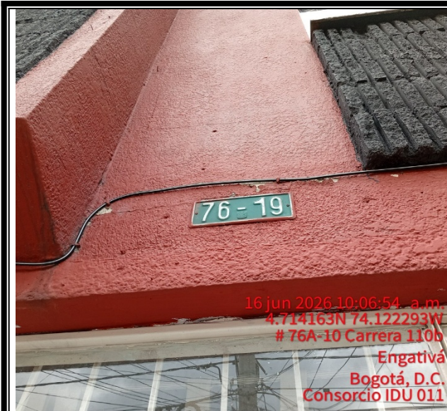
Foto 1: Detalle de nomenclatura de referencia de la visita.
