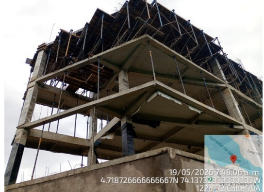
Obra de Iglesia Buenas Nuevas Colombia
