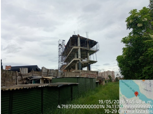
Obra que lleva 5 pisos de elevación
