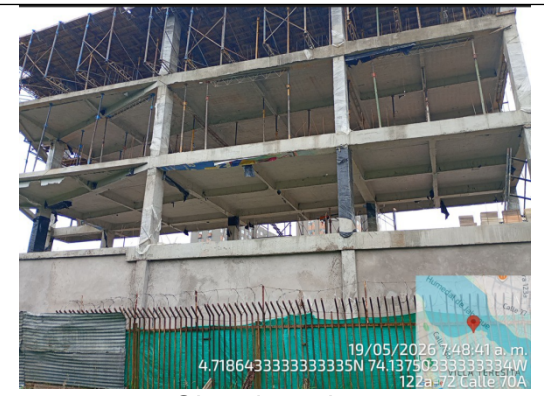
Obra de 5 pisos
