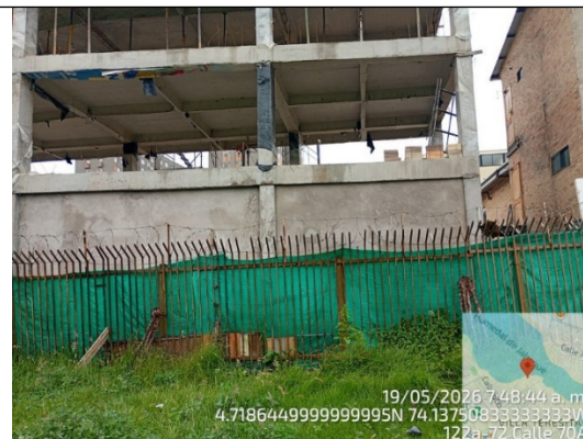
Levantamiento de muro contiguo al Humedal
