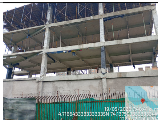
Obra de 5 pisos
