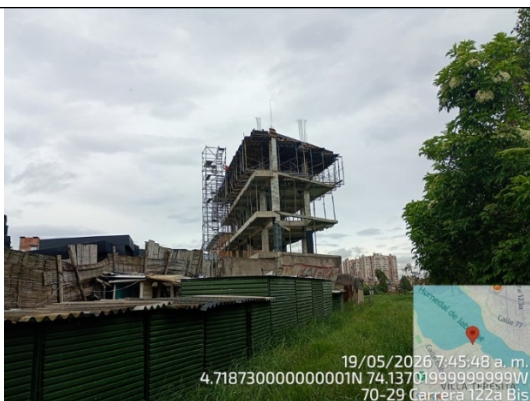
Obra que lleva 5 pisos de elevación
