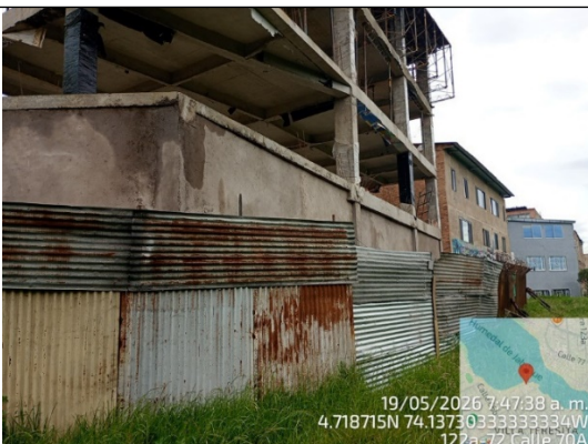
Cierre de aislamiento de su obra
