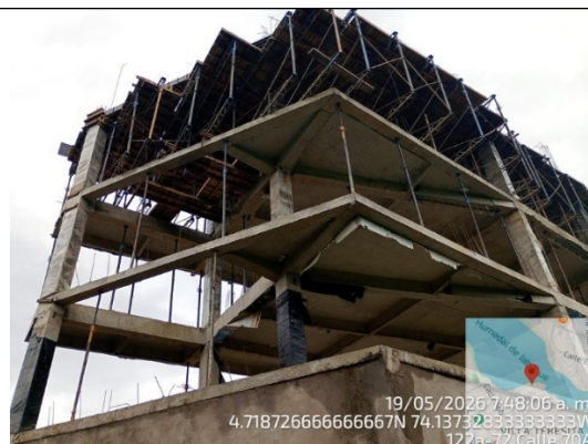
Obra de Iglesia Buenas Nuevas Colombia
