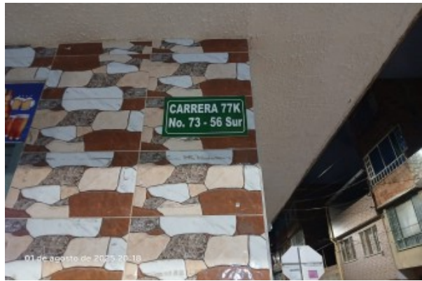
Fotografía No. 2. Nomenclatura expuesta en fachada
