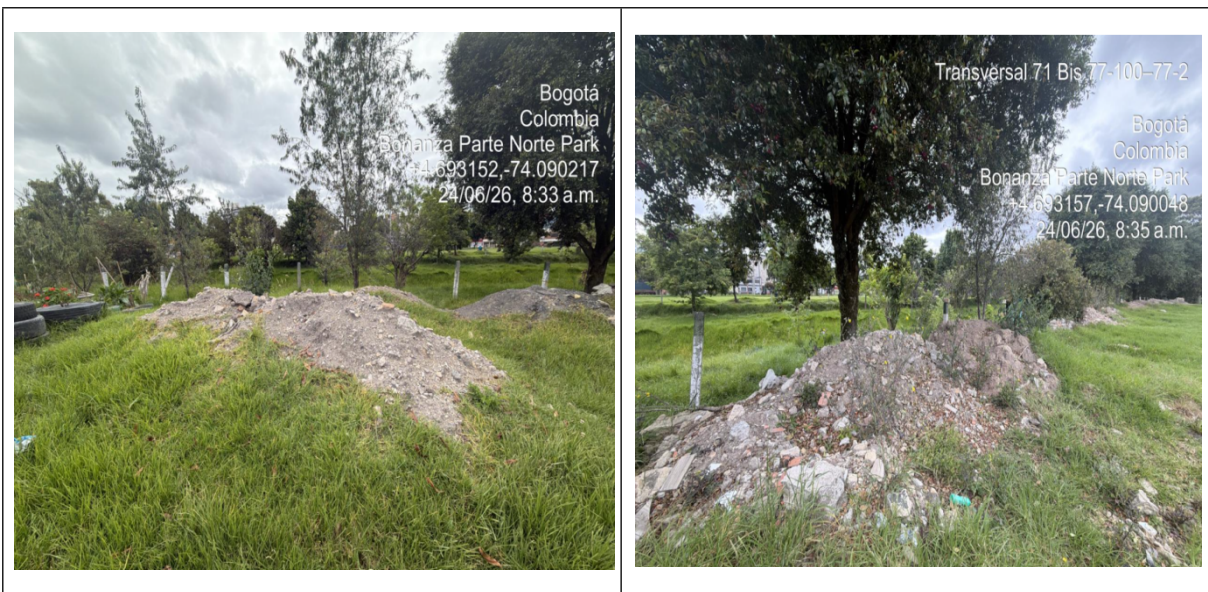
Fotografías No. 1 y 2. Residuos de construcción y demolición en ronda hídrica del canal Bonanza
