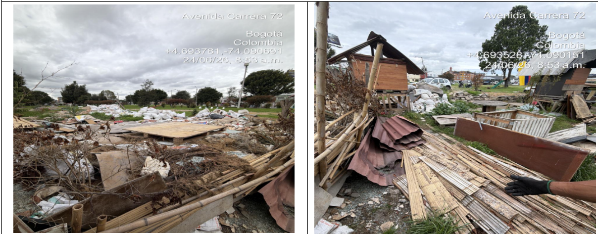
Fotografías No. 3 y 4. Residuos de madera, tejas y lonas de RCD
