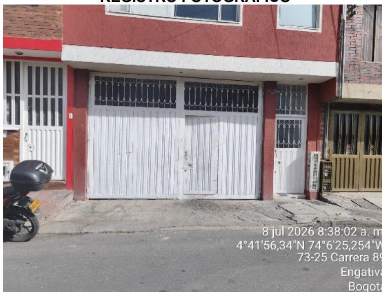
Foto No. 1. Fachada del predio
