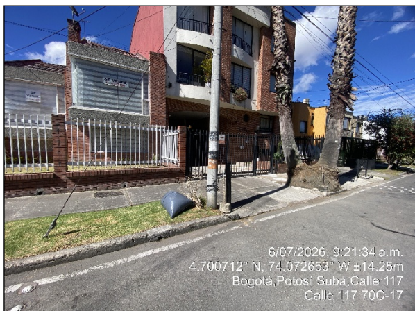
Vista panorámica del sector denunciado Fotografía No. 8
