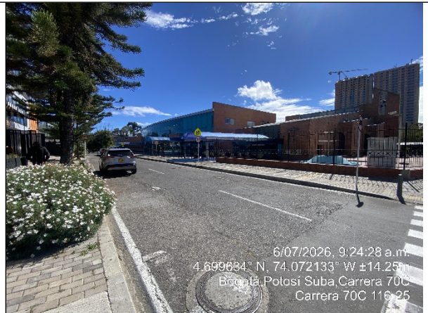
Vista panorámica del sector denunciado
