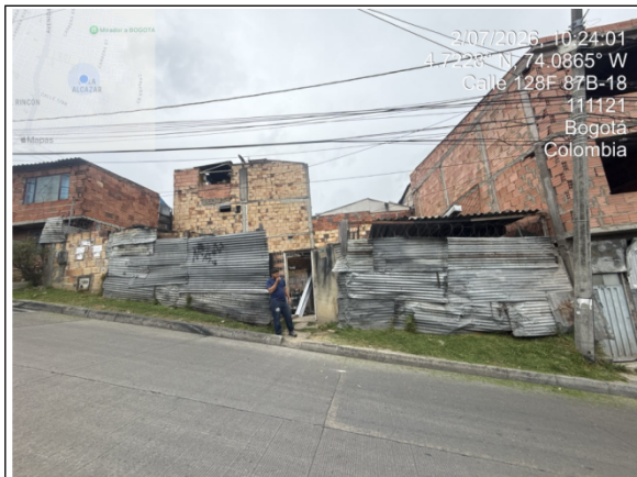
Fotografía No. 1 Fachada del predio
