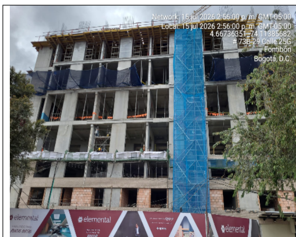
Fotografía No. 1 Vista general del proyecto constructivo desde la calle 25G.
