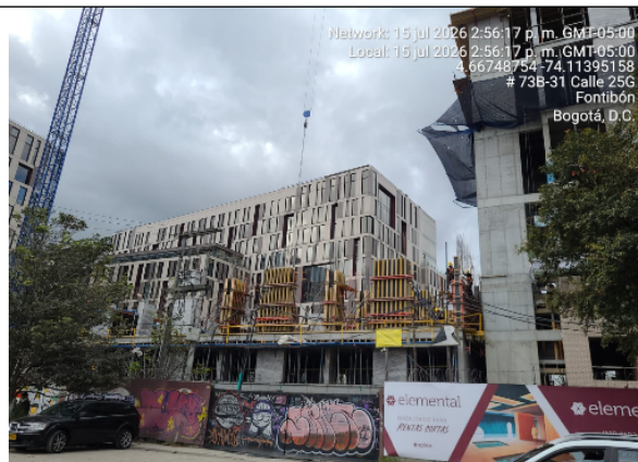
Fotografía No. 4 Frente de obra.
