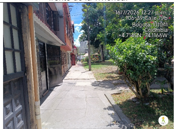
Imagen 4. Ausencia de residuos o afectaciones visibles sobre los canales de aguas lluvias perimetrales.
