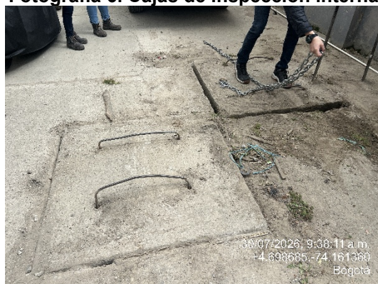
Fotografía 6. Cajas de inspección interna
