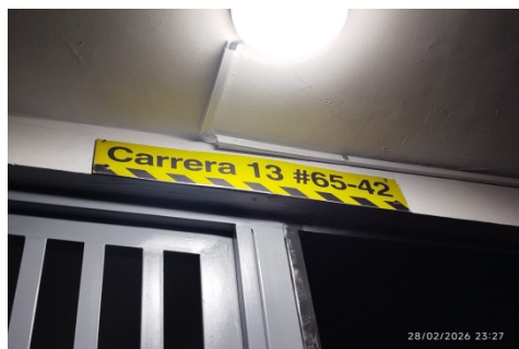
Fotografía No. 3. Nomenclatura expuesta en fachada.
