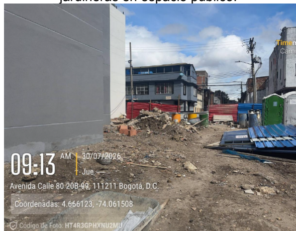
Fotografía 4. Vista interior de la obra.
