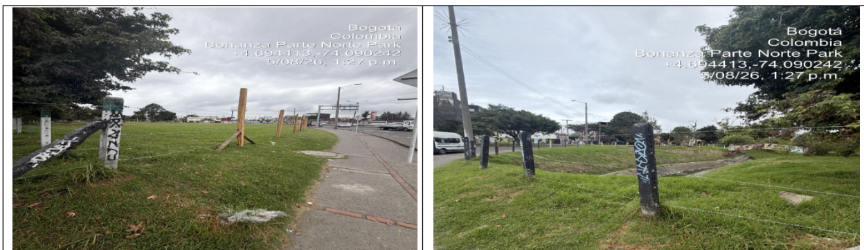
Fotografías No. 3 y 4. Cerramiento perimetral del polígono ubicado en la transversal 71 Bis No. 76-28
