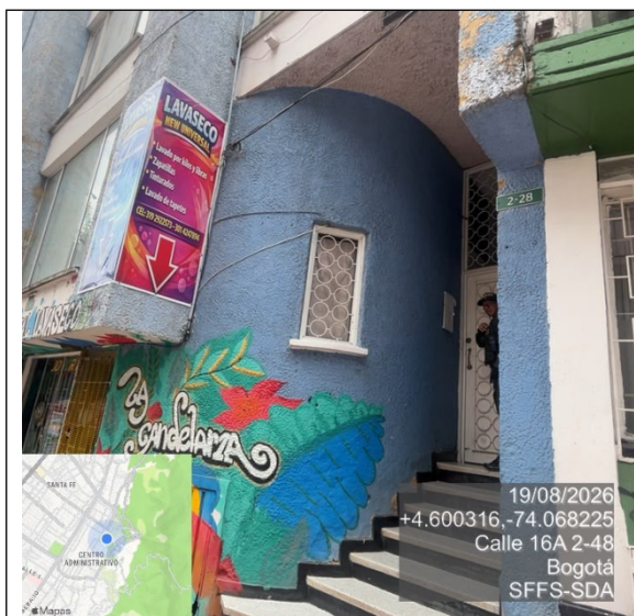
Foto N° 1 – Fachada de la Calle 16A N° 2-28
