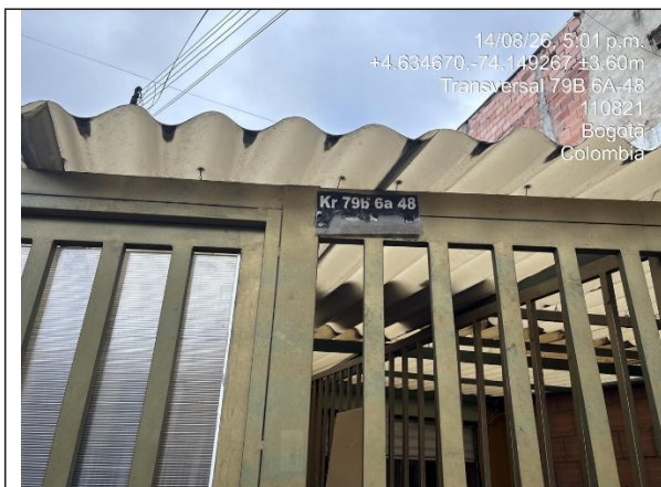
Fotografía 1. Verificación de la dirección del predio objeto de la petición.
