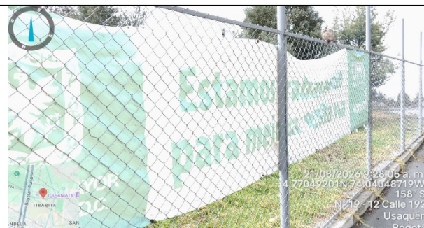
Fotografía 6. Vista malla perimetrial del predio de la UMV en las coordenadas N: 4.7704920 W: - 74.040487.
