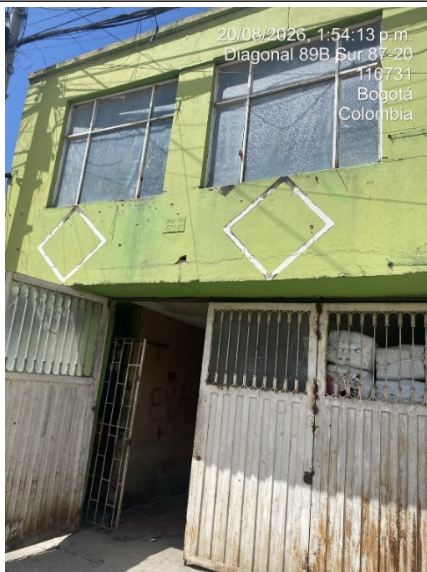
Fotografía No. 1. Fachada del predio dedicado al reciclaje en la dirección referida
