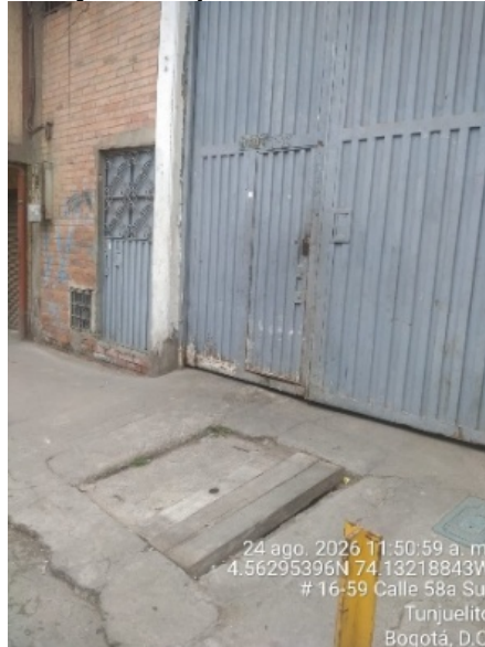
Fotografía 3. Caja de inspección sin vertimientos a la vía
