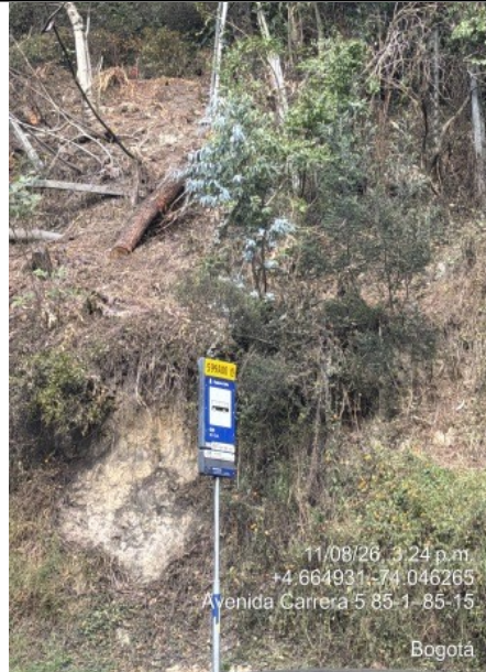
Foto 4. Vista general de la zona.
