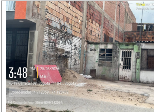
Fotografía 1. Residuos de construcción y demolición en el costado oriental del predio.
