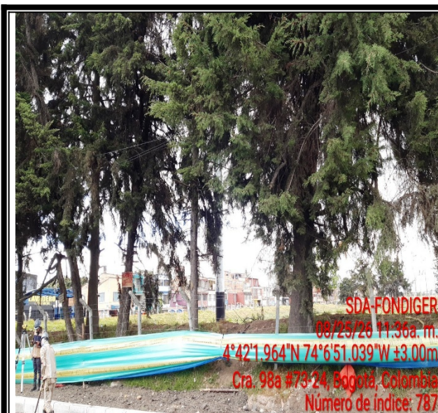
Foto 5: Vista detalle de labores de mejoramiento de la vía ubicada frente a los arboles.
