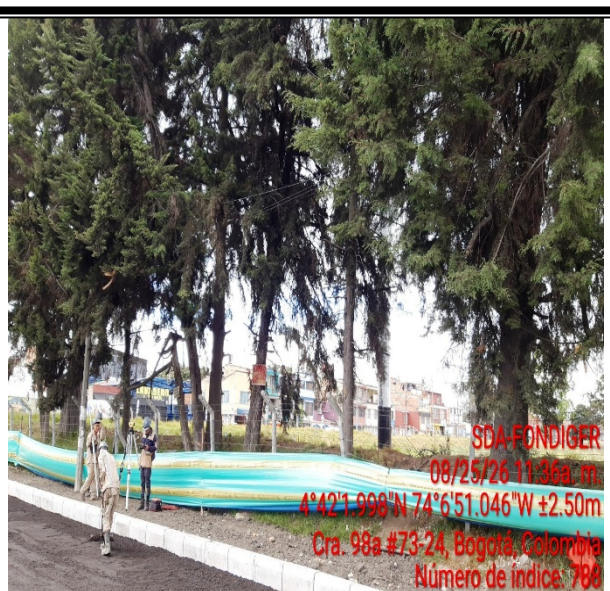
Foto 5: Vista detalle de cambio de bordillo del andén, existe paso peatonal definido y adecuado.
