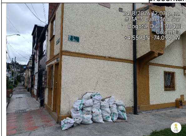
Imagen 3. Acumulación de residuos en muro de la vivienda sobre el espacio público.
