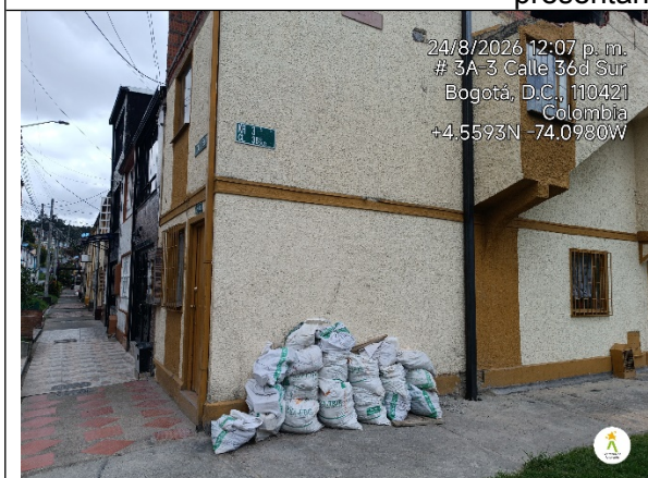
Imagen 3. Almacenamiento de residuos en muro de la vivienda sobre el espacio público.
