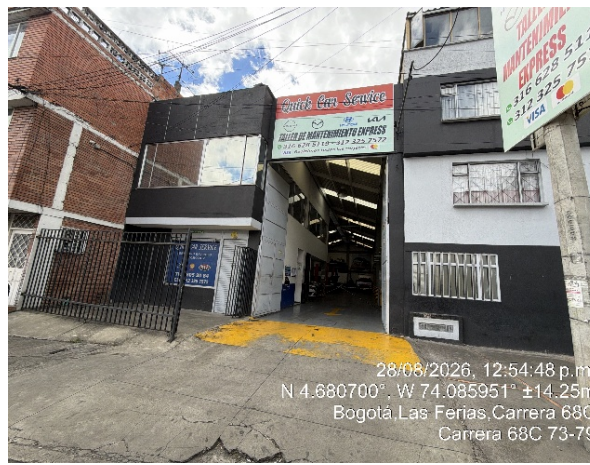
Fotografía No. 2. Vista panorámica del predio donde se ubica el establecimiento comercial denunciado en la CR 68 C NO. 73 – 79 de la localidad Engativá.
