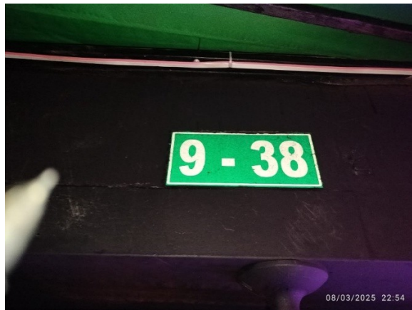
Fotografía No. 42. Vista de la nomenclatura expuesta en fachada de la CL 59 No. 9 - 36.
