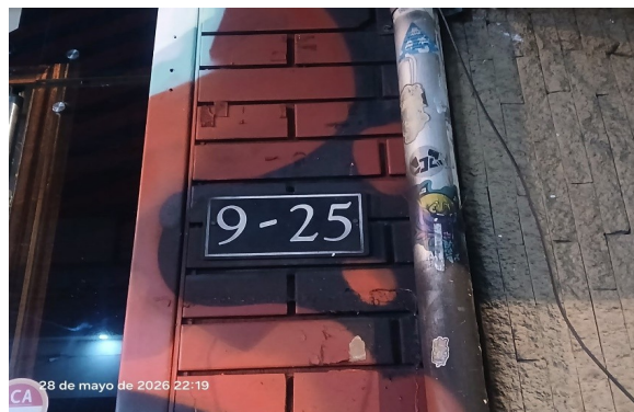
Fotografía No. 44. Vista nomenclatura secundaria expuesta en fachada.
