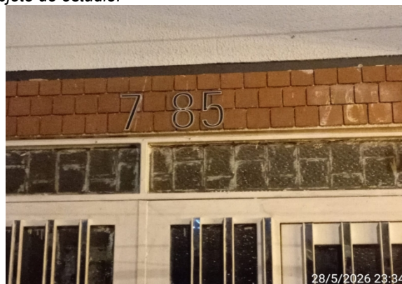
Fotografía No. 53. Nomenclatura expuesta en fachada.
