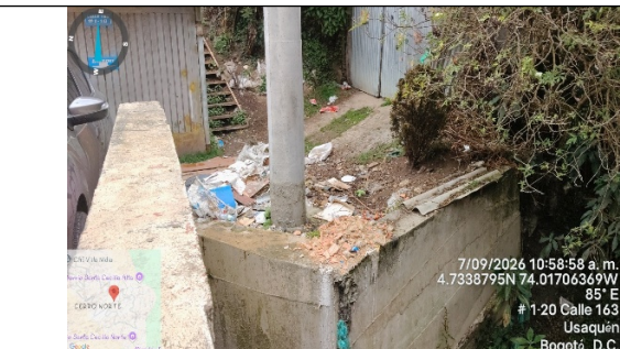
Fotografía 7. Residuos de construcción y demolición - RCD dispersos en cantidad aproximada de 0.3m 3 .
