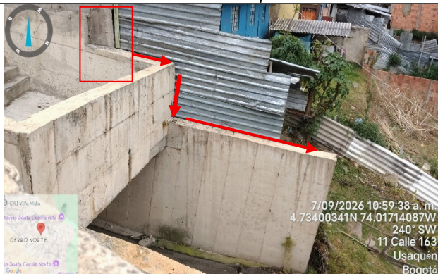
Fotografía 6. Se observa el muro de contención correspondiente al tramo canalizado de la quebrada San Cristóbal. En el recuadro se evidencia la diferencia de espesor entre el muro de la obra hidráulica y el muro de cerramiento de la vivienda colindante, permitiendo establecer una diferenciación física entre ambas estructuras.
