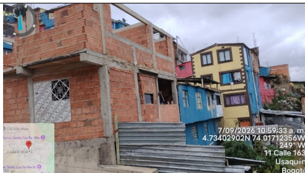
Fotografía 4. Vista lateral de la vivienda con parte del fondo encerrado en lámina. Se observa que esta continua a la infraestructura del muro de la quebrada San Cristóbal.
