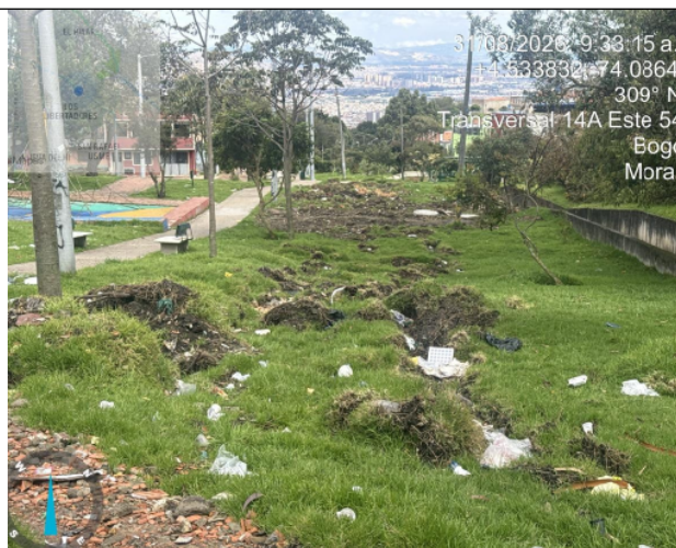
Fotografía 2. Se evidencia posible riesgo de afectación de la ronda hídrica asociado a actividades de excavación, que han generado el levantamiento y fragmentación de la cobertura de césped, dejando expuestas franjas y montículos de suelo. Asimismo, se observa la presencia de una mezcla de suelo con RCD, además de presuntos cortes y agrietamientos en la cobertura vegetal que podría favorecer procesos erosivos, especialmente ante eventos de precipitación o lluvias de alta intensidad. Lo anterior se presenta en las coordenadas 4.533832, -74.086498
