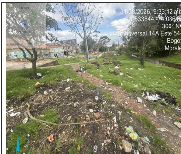
Fotografía 1. Se evidencia aparente compactación del suelo y alteraciones en la cobertura vegetal, asociadas a procesos de excavación, remoción de la capa orgánica y erosión, en las coordenadas 4.533844, -74.086484 (Transversal 14A Este 54-2, Bogotá). En el área intervenida se observa presencia y disposición inadecuada de residuos de construcción y demolición (RCD), tales como fragmentos de ladrillo, losa y concreto, mezclados con suelo expuesto y residuos sólidos ordinarios, entre los que se identifican plásticos, empaques, bolsas y residuos domésticos. Asimismo, se evidenció pérdida de continuidad del estrato herbáceo, producto del levantamiento y fragmentación de la cobertura de césped, generando áreas con suelo desnudo, montículos y discontinuidades en el terreno.
