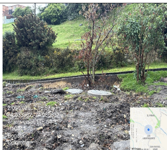
Fotografía No. 4. Instalación estructura de alivio.
