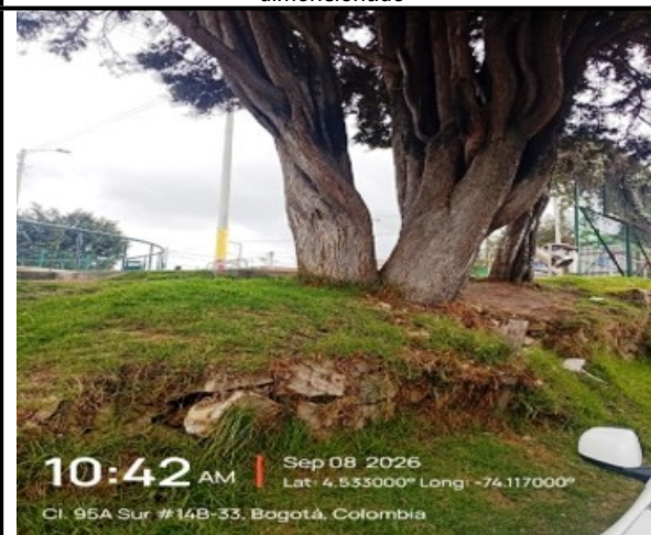
Foto No 4 Detalle zona de emplazamiento con afectación, mal anclaje del árbol
