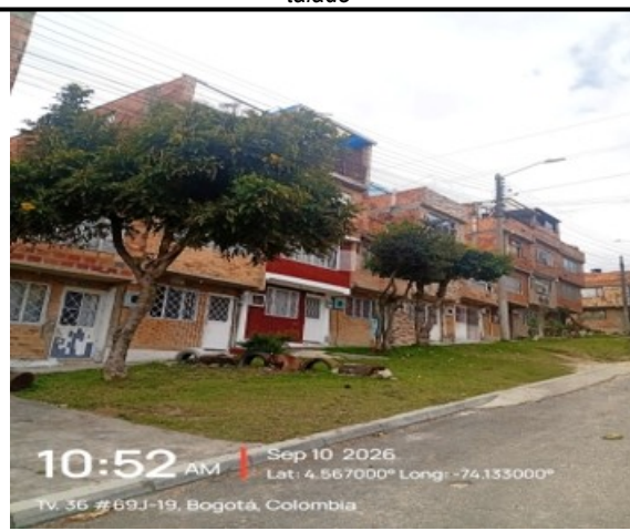
Foto No 4 Vista general del sitio, no se aprecia arbolado talado
