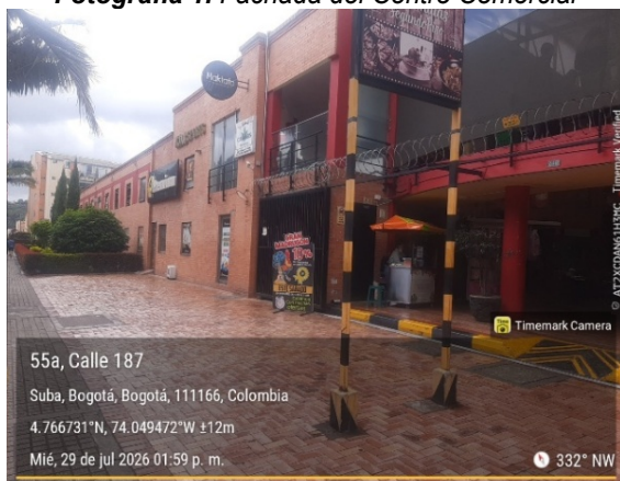
Fotografía 1. Fachada del Centro Comercial
