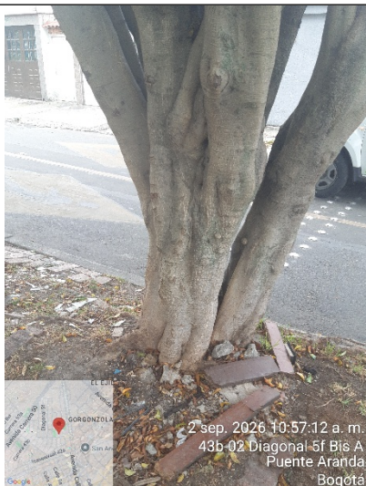
Fotografía 5: Vista general del fuste
