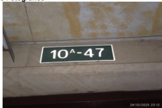
Fotografía No. 2. Nomenclatura expuesta en fachada
