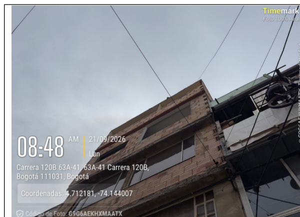
Fotografía 1. Vista general del predio.
