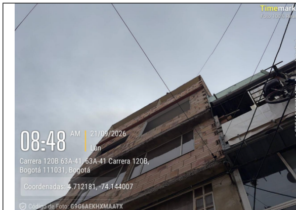
Fotografía 1. Visita general del predio ubicado en la carrera 120 B No. 63 B – 38.
