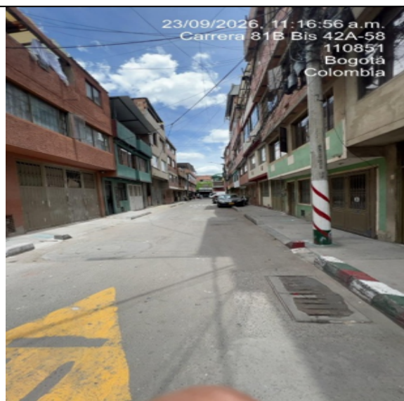
Fotografía Nro.6 . Vista general de la zona.
